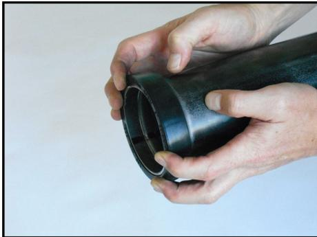
Schieben oder ziehen Sie die Dichtung vorsichtig so weit über ein Rohrende, bis die Schnittkante des Rohrendes wieder sichtbar wird.
