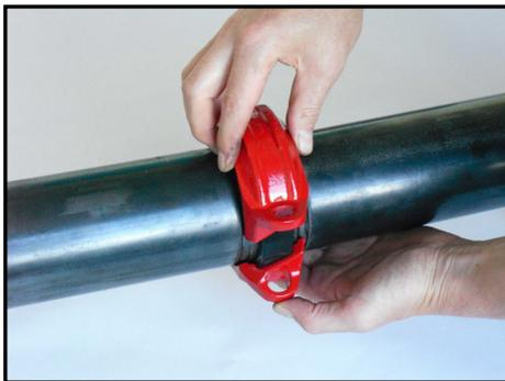
Setzen Sie auch die 2. Gehäusehälfte so an der Dichtung an, dass die Zungen in die Nuten der Rohrenden eingreifen.
